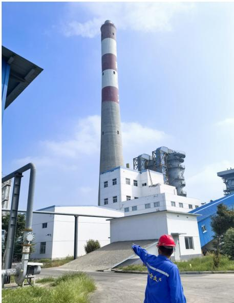
布袋除尘器除尘+SNCR-SCR脱硝+脱硫除尘一体化装置（湿式氨法脱硫+超声波除尘）
